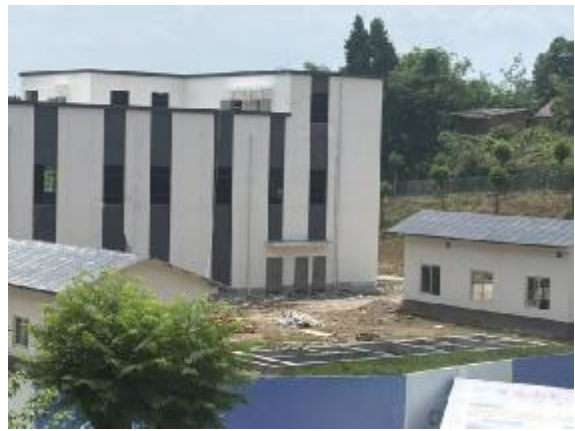
项目主体以及绿化、边坡
