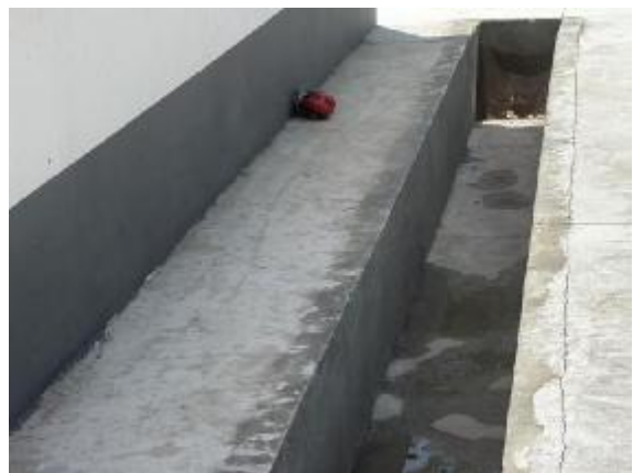
水保措施（排水沟）
