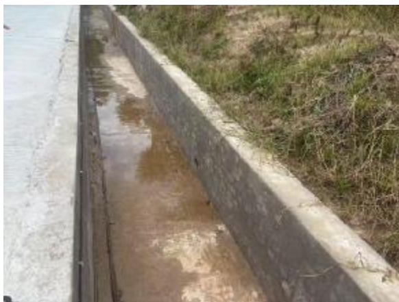
水保措施（排水沟）
